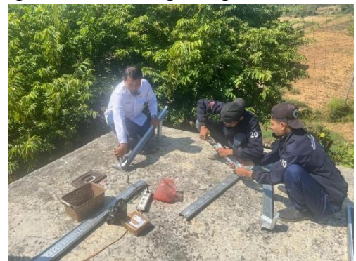
Gambar 18. Pemasangan Rangka Panel Surya
